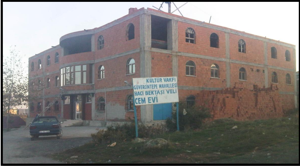
Acısu Cem Evi halen inşaat halindedir. Maddi kaynak yetersizliğiyle bir dönem daha bu şekilde kalacağına benzemektedir, Gökçen Çatlı Özen, 18.10.2011
