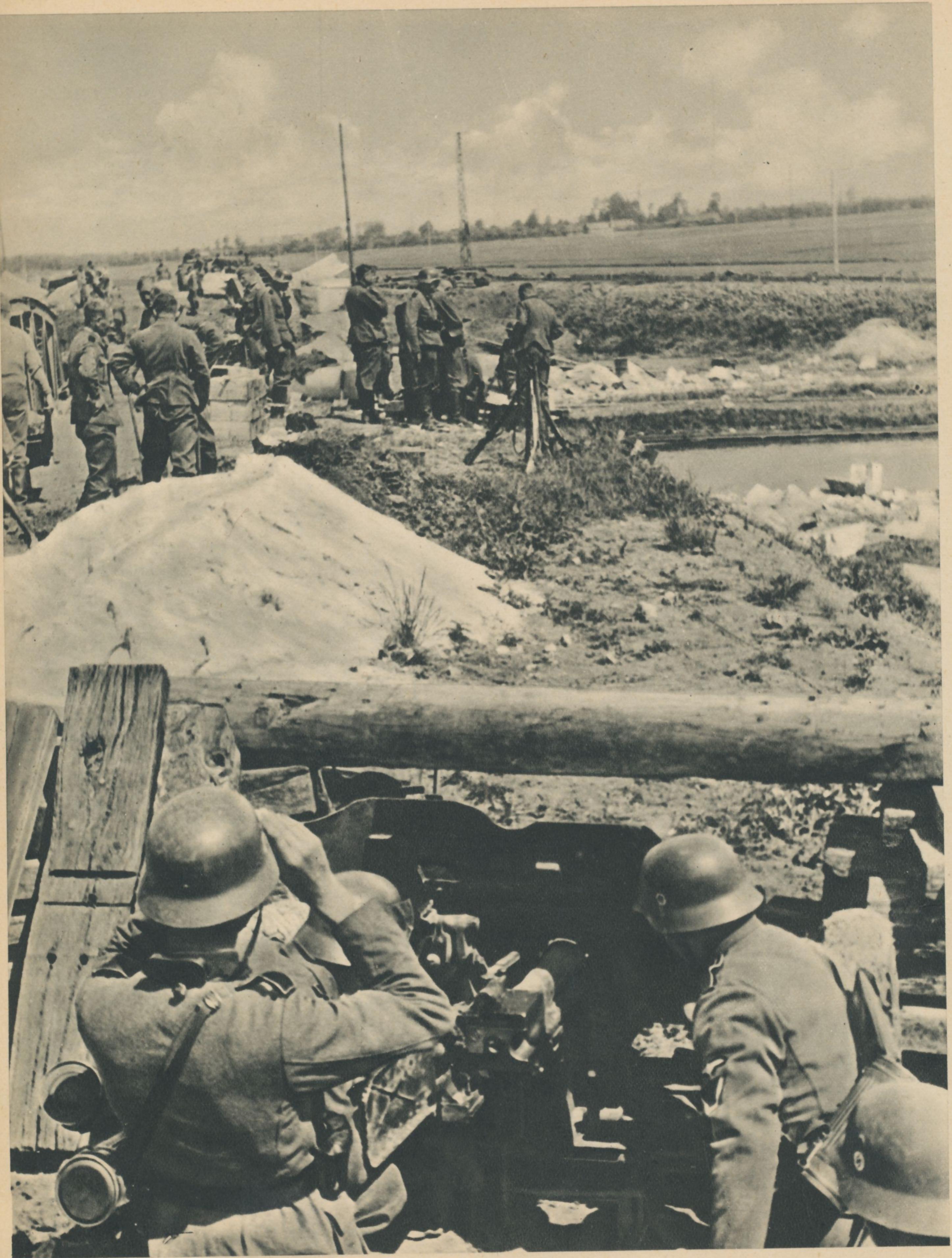
So unbekümmert sich die Kameraden beim Brückenbau am La Bassée-Kanal zu bewegen scheinen, es piff damals doch ganz lebhaft von Robecq herüber. Eine Pak sicherte die Arbeit an der Brücke gegen Überraschungen durch feindliche Panzer
