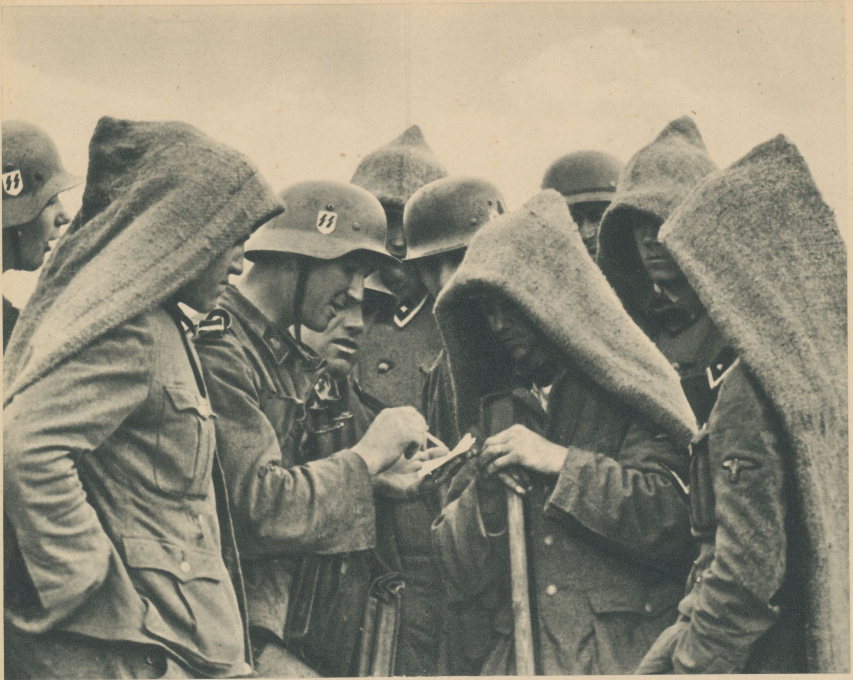
Kapuzenmänner? Das Baukommando an der Brücke schützt sich vor dem nieselnden Regen mit übergestülpten Säcken
