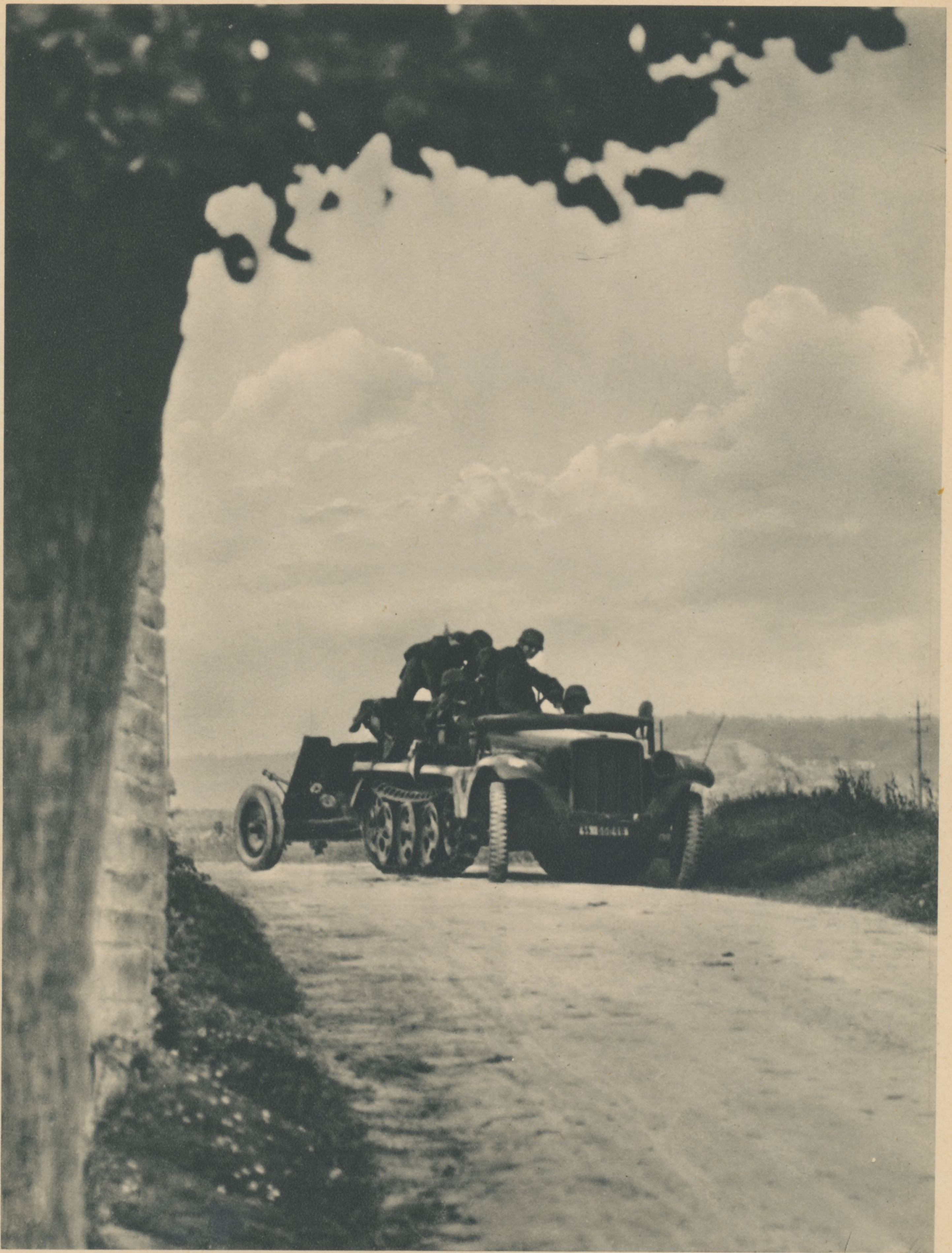
«Pak nach vorn!» — Wie die leibhaftigen Teufel preschen die Fahrzeuge nach vorn, und Sekunden später steht die Pak schon feuerbereit in der Straßenkurve
