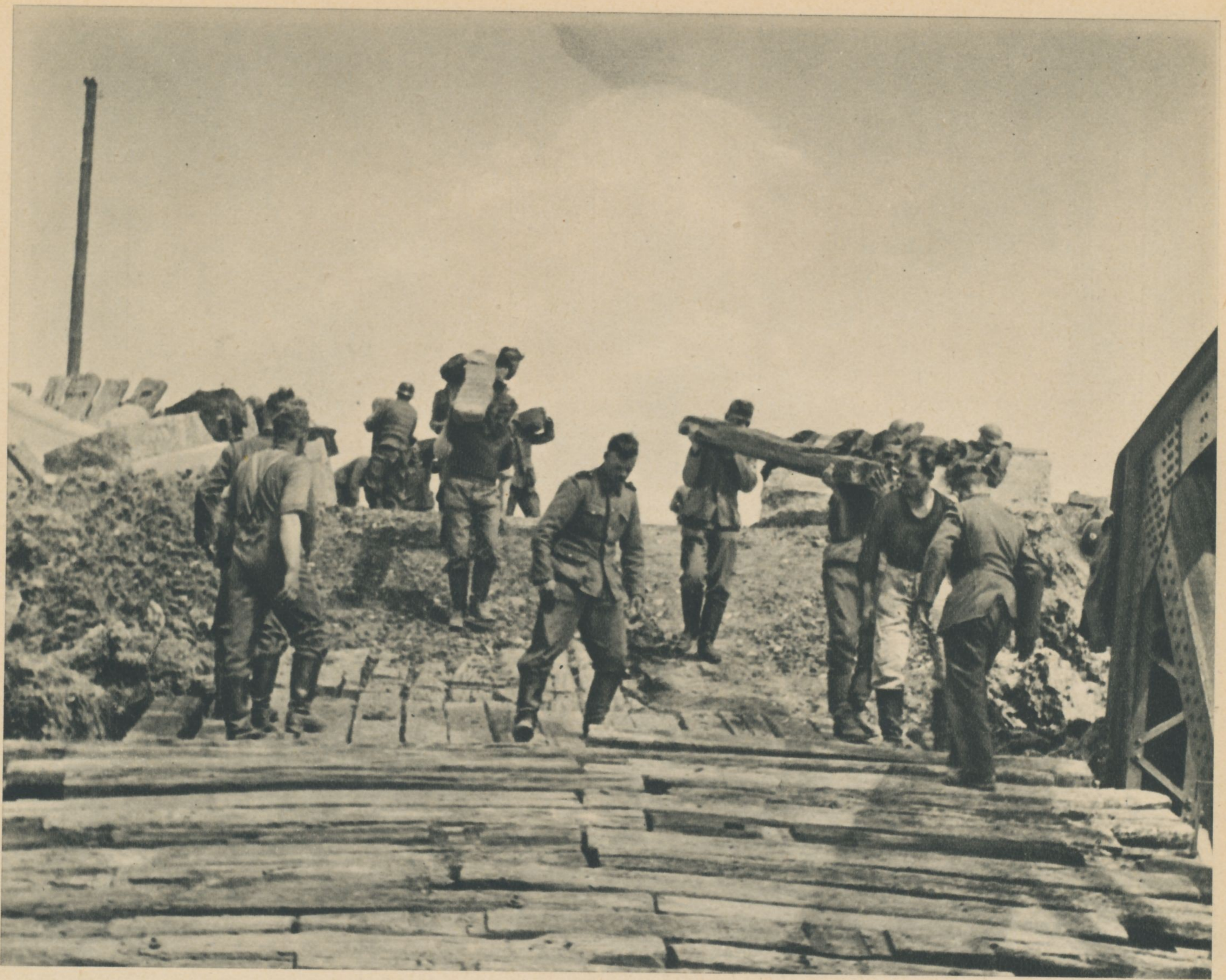
Trotz Kugelgezwitscher bauen die Pioniere der W in aller Seelenruhe die von den Tommys gesprengte Brücke wieder auf. Kurz darauf mußten sie ihr Werk wieder in die Luft jagen, um sie dann wenig später nochmals aufzubauen
