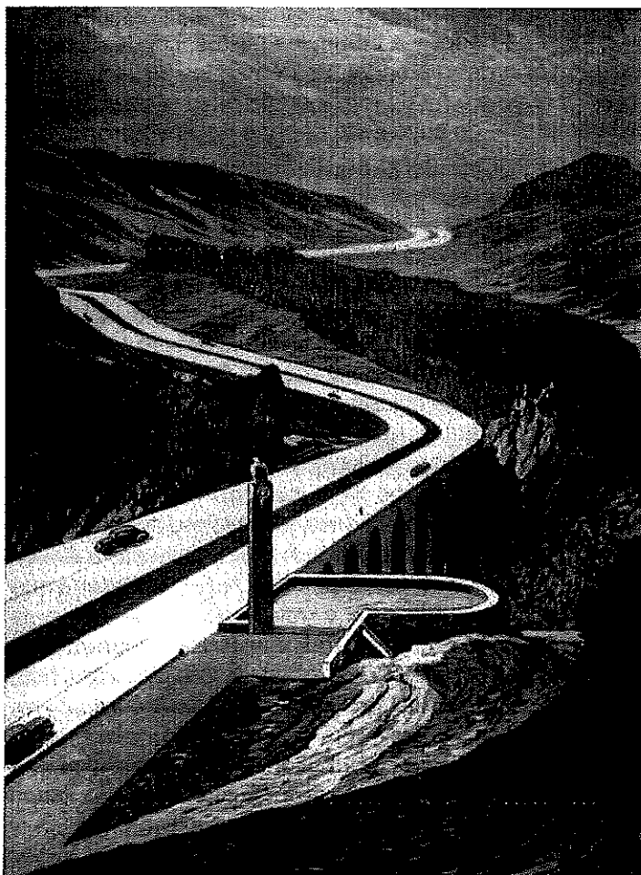
La construcción de supercarreteras fue un medio para dar empleo.
