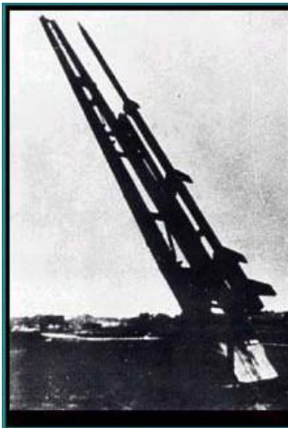
Der "Rheinbote." Eine der ersten Mehrstufenraketen - geschaffen in Deutschland 1943/44. Die Ähnlichkeit mit den um Jahrzehnte später erschienenen ausländischen Raketen, die sämtlich auf Beute aus Deutschland basierten, ist unverkennbar.
