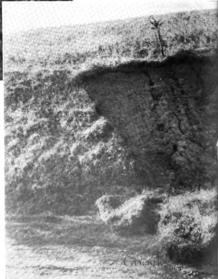
Erdrutsch im Kreise Nimptsch (Schlesien) als Folge starker Niederschläge, deren Wirkung nicht durch entsprechende Vorsichtsmaßnahmen gehemmt wurde
