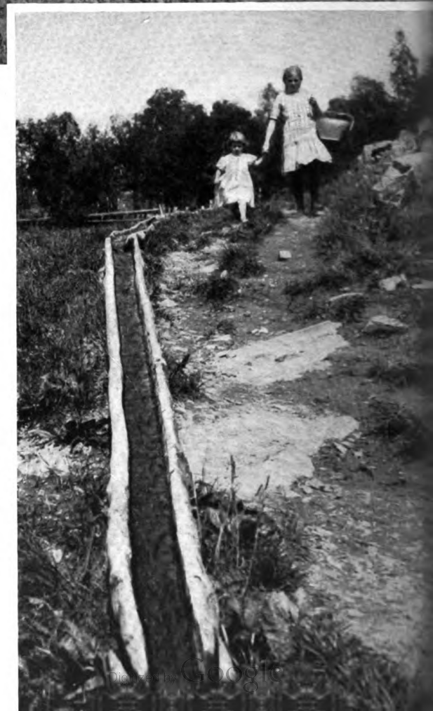
Rechts: Bewässerungsanlage für trockene Bergwiesen
