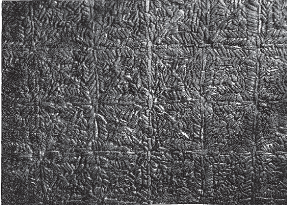
Fig. 6: Artful flett fußboden im Bauernhause, zusammengesetzt aus Bach- pebble. Soltau district (north).
