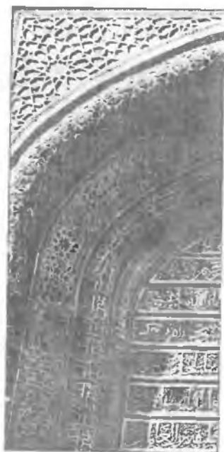
Медресе аль-Мустанси- рия. Багдад. XIII в.: главный вход
