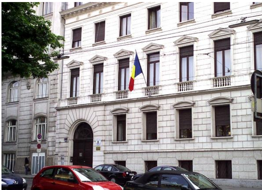
Clădirea Ambasadei României la Viena.
