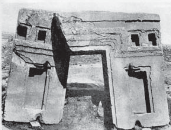
b. Sun Door seen from the rear (year 1904). Puerta del Sol, vista de atrás (año 1904).
