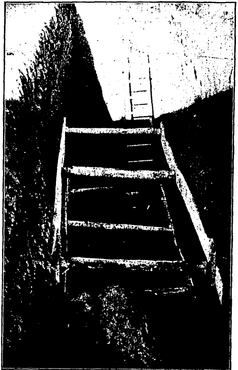
2. Der zur Untersuchung der Brunnen- sohle gegrabene Schacht im Quergraben Nr. VI (Punkt 97).
