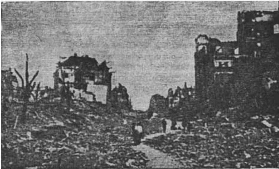
El 13 de mayo de 1943 Churchill convino con Roosevelt en extremar el "experimento" para hacer que Alemania se rindiera mediante bombardeos de terror. Esta escena es de Plauen, Alemania. Los civiles buscan entre los escombros de sus viviendas algo que haya quedado útil. 2.700.000 toneladas de bombas...
