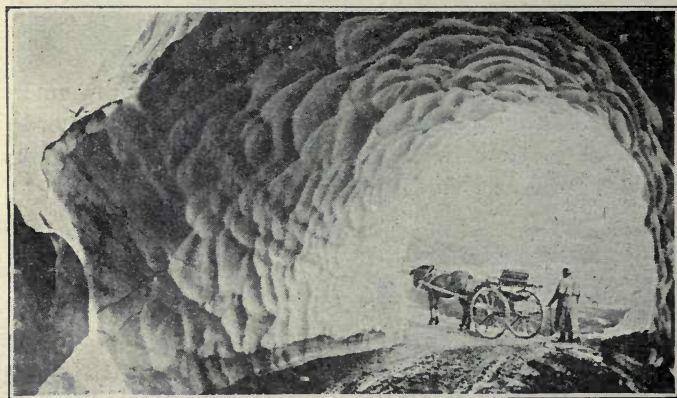
Snetunnel ved Haukelid.
