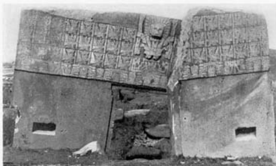
a. Sun Door in front view (year 1904). Puerta del Sol, vista de frente (año 1904).
