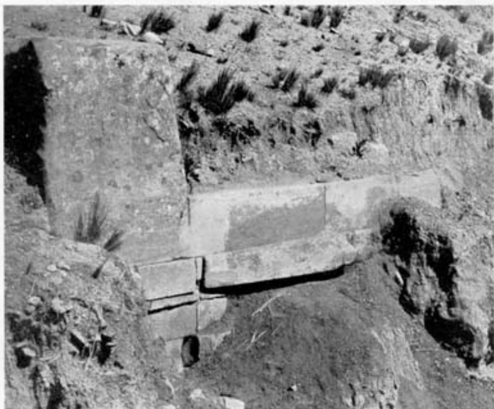
b. East retaining wall of Akapana. Pared de contención Este de Akapana.
