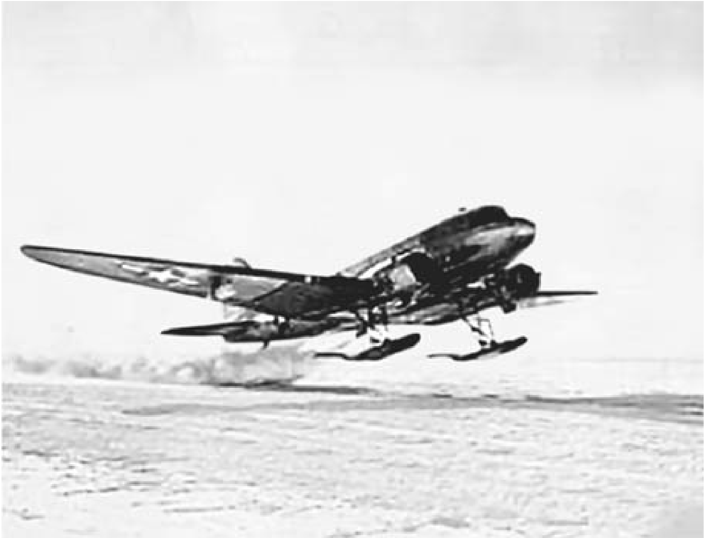
Uno de los R4D despegando de Little America IV. Se puede ver el sistema de skis en lugar del tren de aterrizaje convencional
